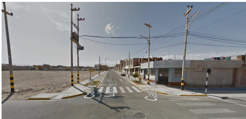
Imagen N° 31: Estado de Conservación
