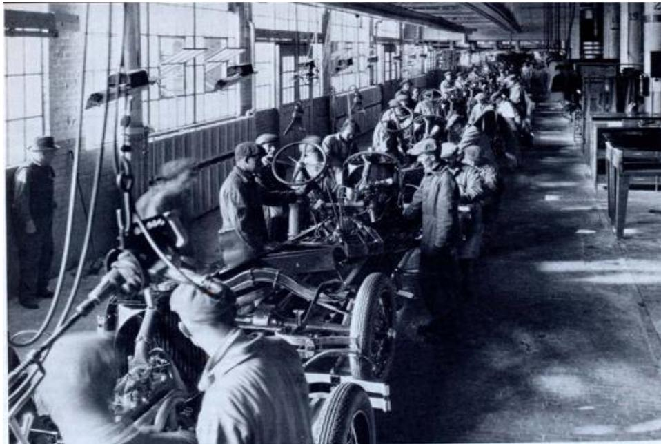
Figura 3. Imagen de la cadena de montaje ideada y perfeccionada por Ford
