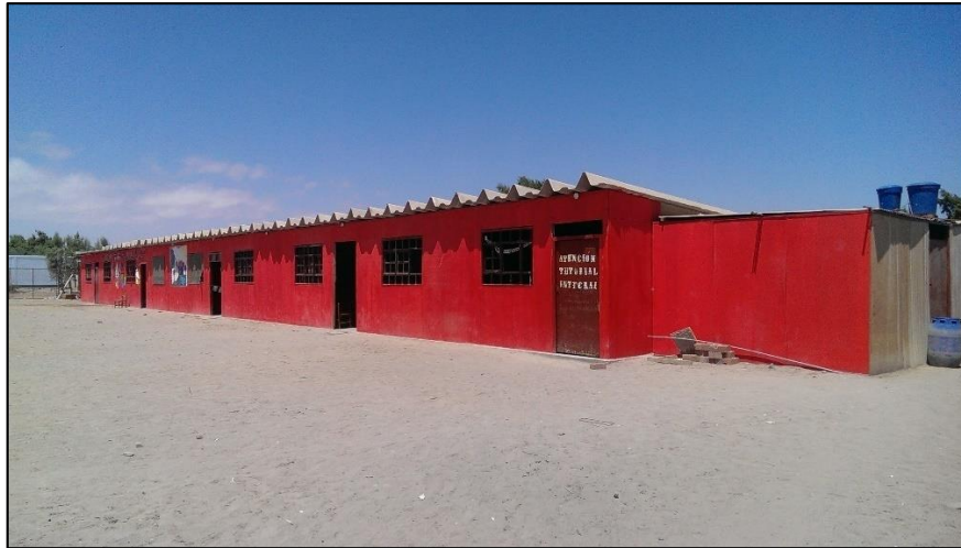
FIG Nº 15 - AULA PREFABRICADA – COLEGIO ALFONSO UGARTE (fuente: Propia)
