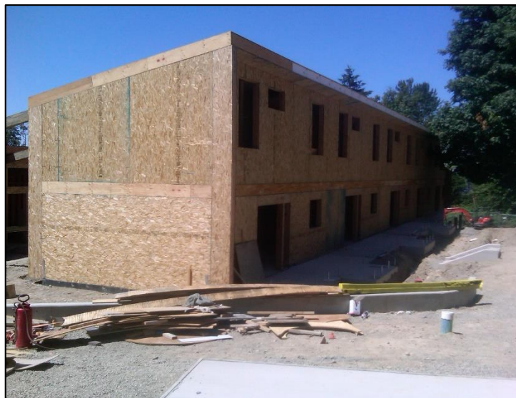
FIG N° 38 - CONSTRUCCION CON SISTEMA SIP (fuente: SIP SYSTEM Perú)
