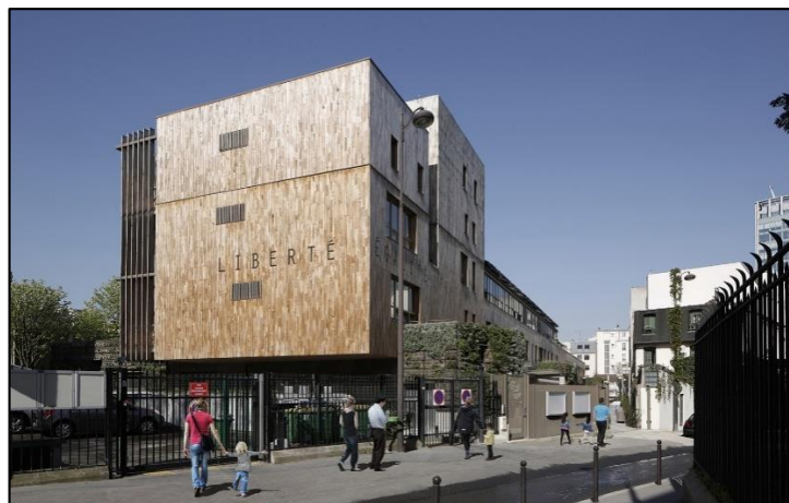
FIG Nº 3-FACHADA PRINCIPAL ECO GUARDERIA Y ESCUELA BASICA (fuente: Plataforma Arquitectura)
