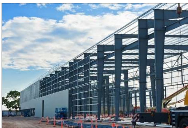
IMAGEN 43: SISTEMA ESTRUCTURAL DE ARMADURA METALICA
