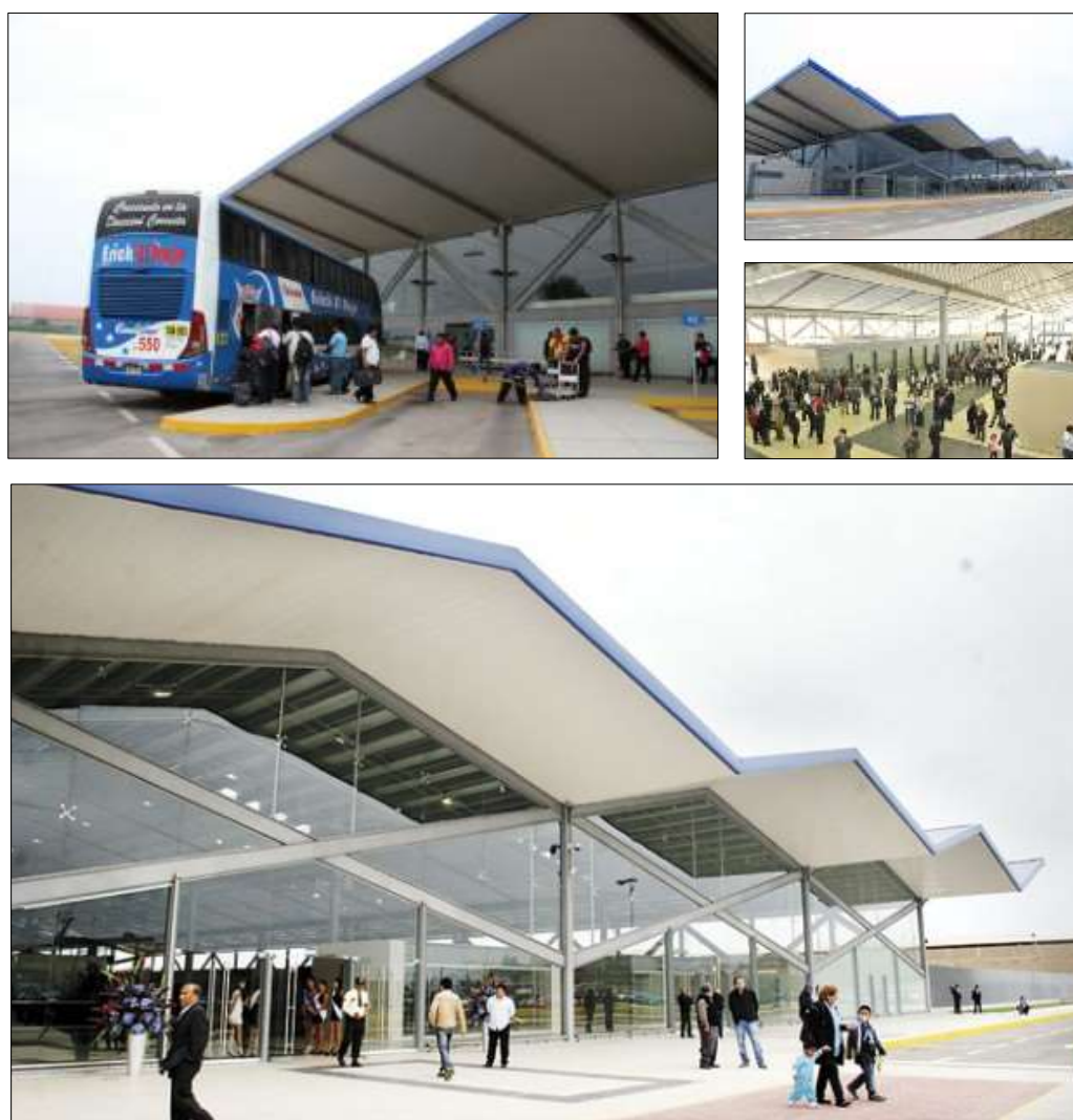
FIGURA N° 41: VISTA INTERIOR Y EXTERIOR ZONA DE EMBARQUE Y DESEMBARQUE DE PASAJEROS
