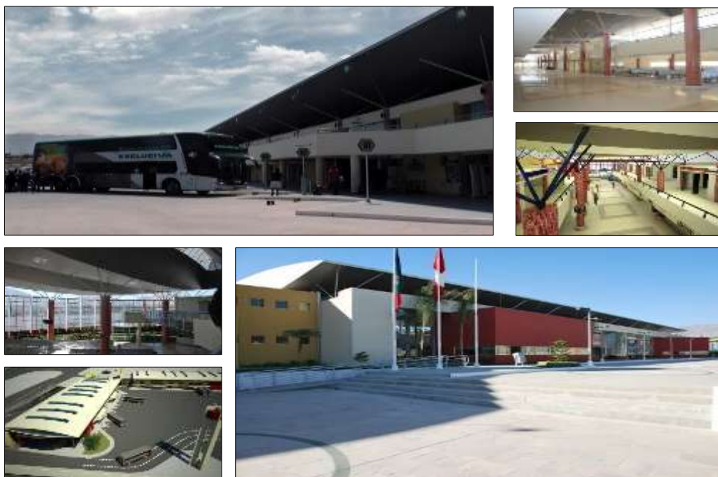
FIGURA N° 40: VISTA INTERIOR Y EXTERIOR ZONA DE EMBARQUE Y DESEMBARQUE DE PASAJEROS
