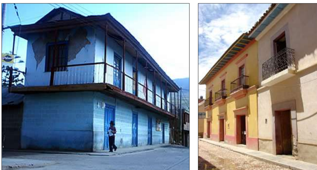
IMAGEN 13: Arquitectura de Casa típica en Candarave (izquierda) – Arquitectura de casa típica en Tarata (derecha)
