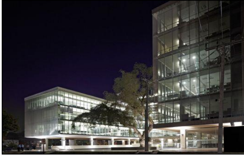
Figura N° 6: Fachada de la Municipalidad de Recoleta.
