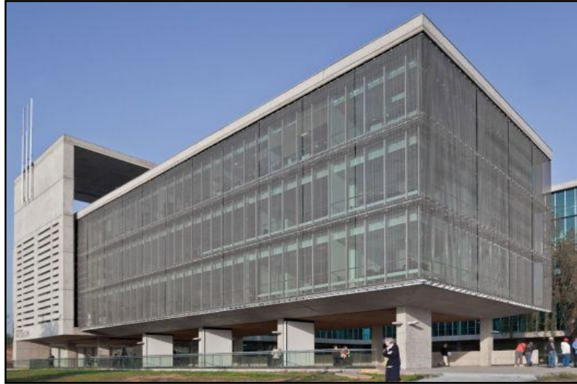
Figura N° 10: Fachada lateral de la Municipalidad de Recoleta.
