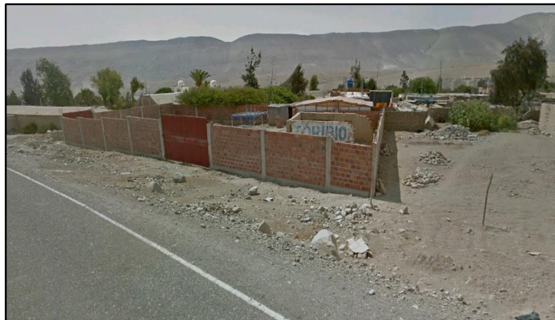
IMAGEN N° 16 ALTURA DE EDIFICACIÓN
