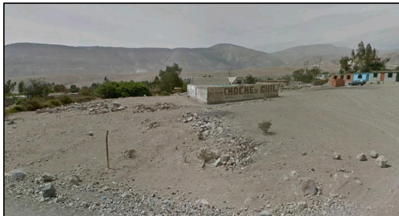
IMAGEN N° 17 ESTADO DE CONSERVACIÓN
