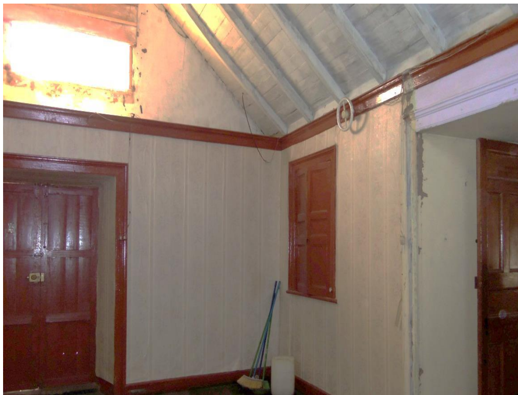
Vista interior, papel mural en muros y ausencia de ventana
