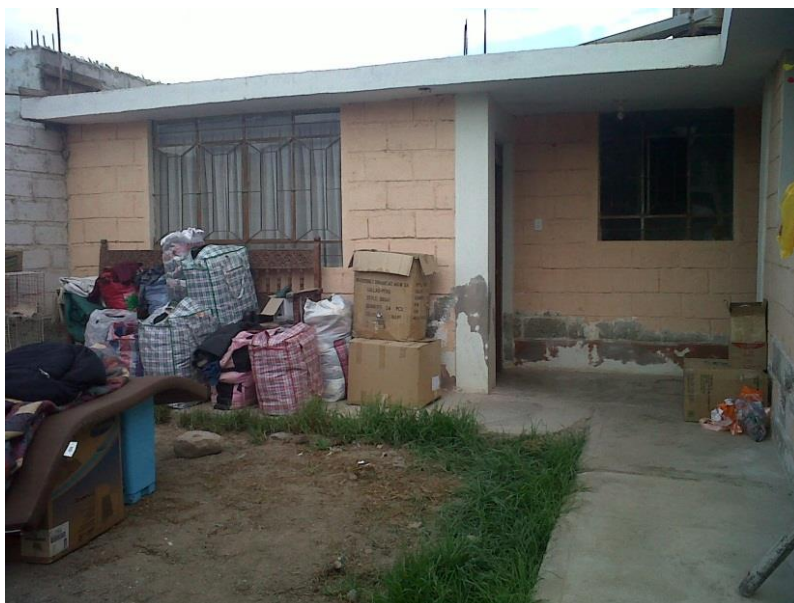
Imagen 58: Vista del comedor y depósito, se observa cómo se encuentran actualmente las donaciones y otros elementos ubicados en el espacio exterior.
