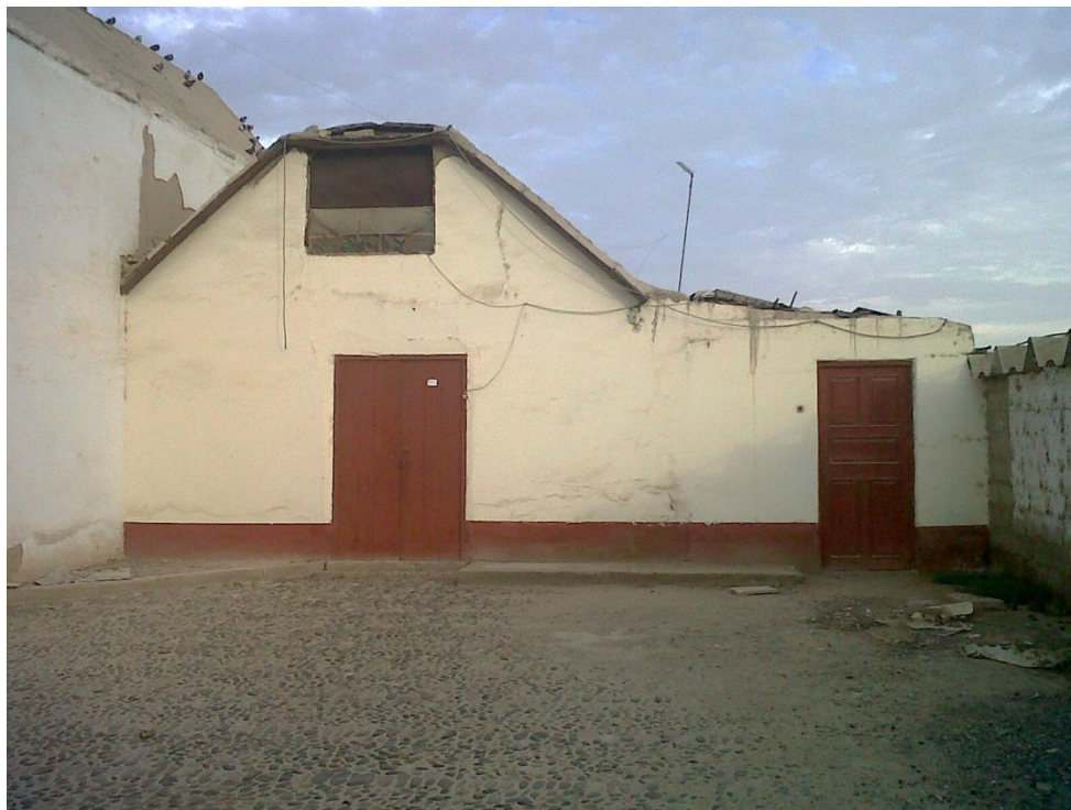
Fachada principal de antigua sala- comedor de las hermanas canonesas
