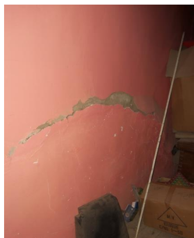
Imagen 17: Vistas de muro que circunda el Altar Mayor, observese los desprendimientos y agrietamientos.
