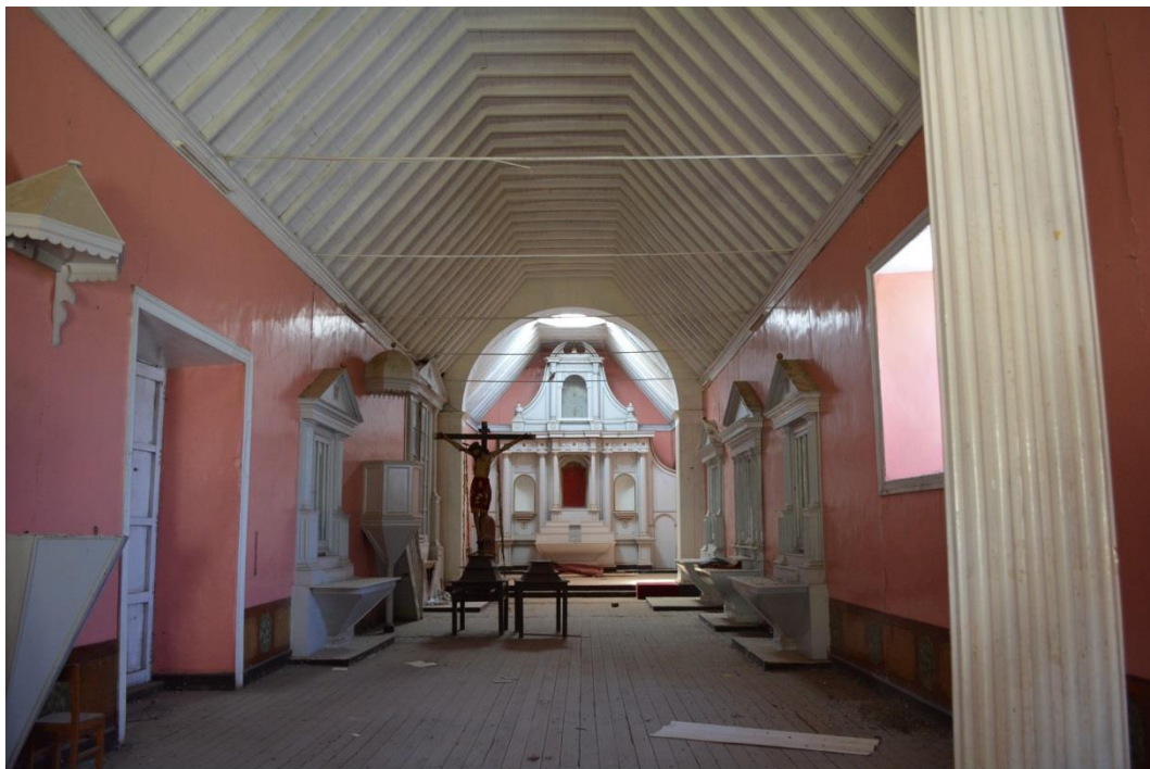
Vista del estado actual interior de la Iglesia, nótese que han sido retirados todo equipamiento e imágenes que la adornaban.
