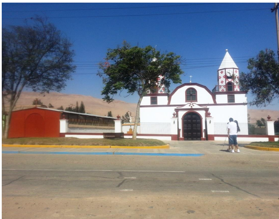
Vista del estado actual exterior de la Iglesia, nótese la construcción provisional del lado izquierdo (terreno contiguo a la Iglesia)
