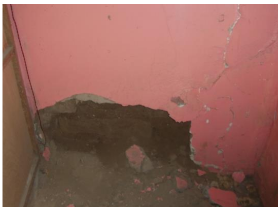
Imagen 17: Vistas de muro que circunda el Altar Mayor, observese los desprendimientos y agrietamientos.
