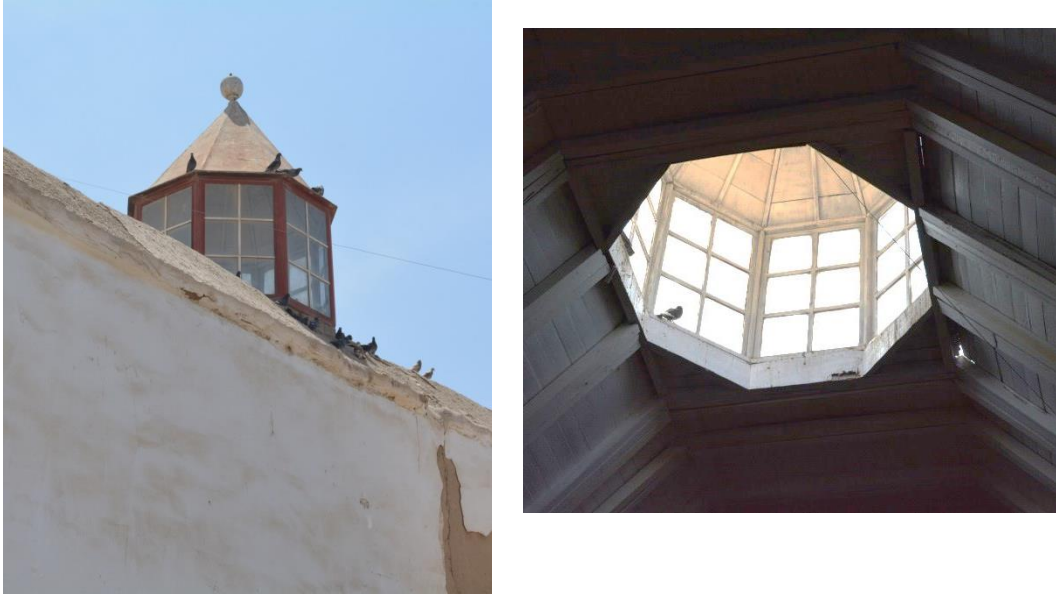
Imagen 48: Vistas de tragaluz octogonal interior y exteriormente ubicado sobre techo mojinete..
