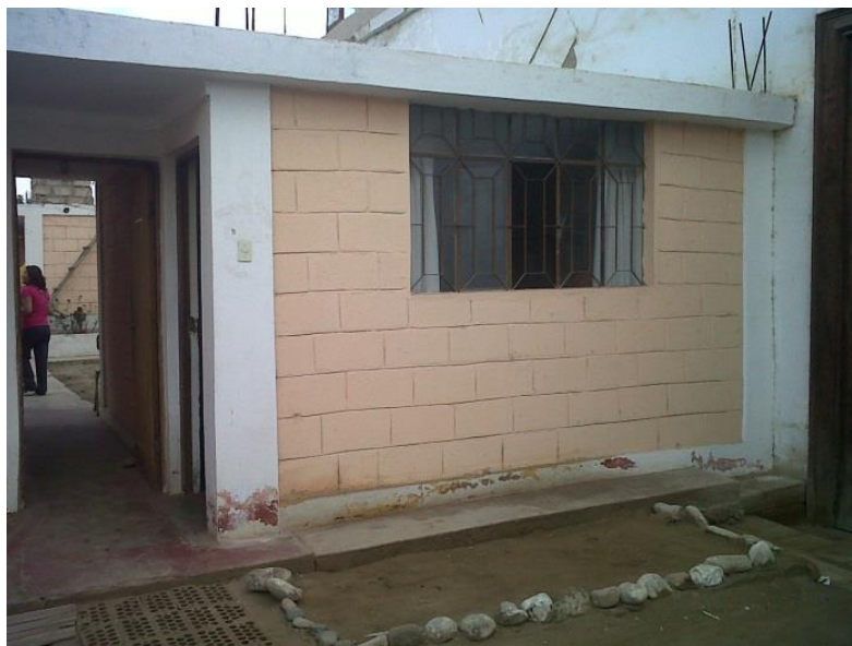
Imagen 53: Vista de ingreso a la vivienda cural actual.
