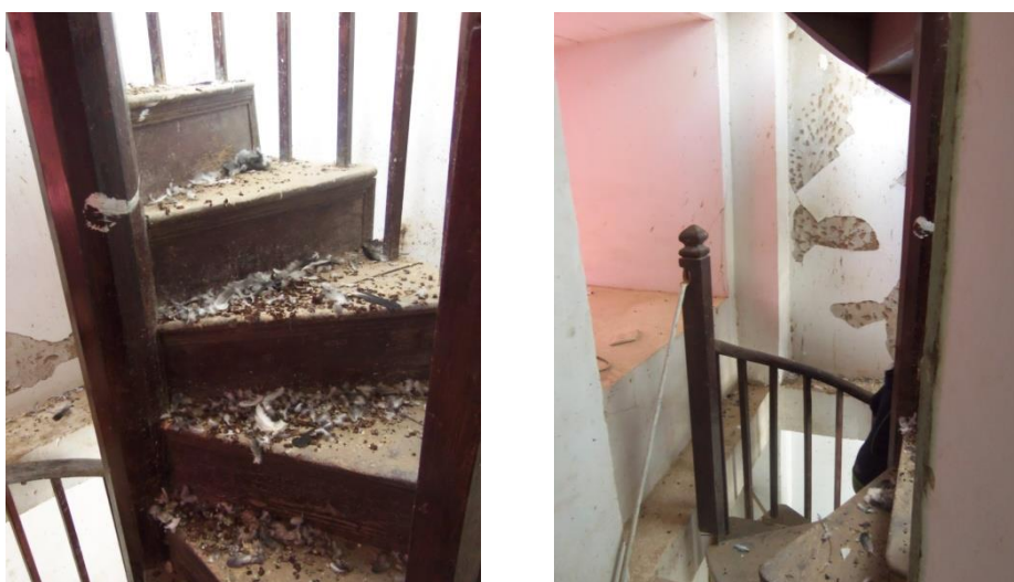
Imagen 33: Vista de escalera de caracol ubicada en el campanario, único acceso al coro y al balcón exterior de la torre
