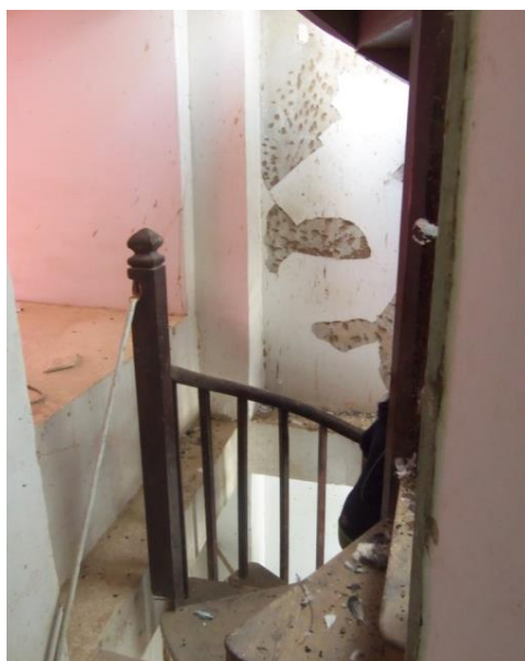
Imagen 36: Vista de estado actual de muros en campanario
