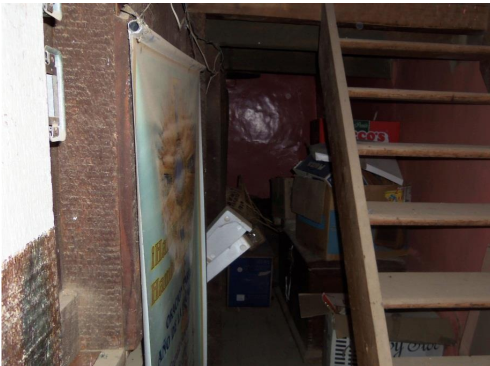
Vista de Espacio ubicado al lado posterior del Altar Mayor
