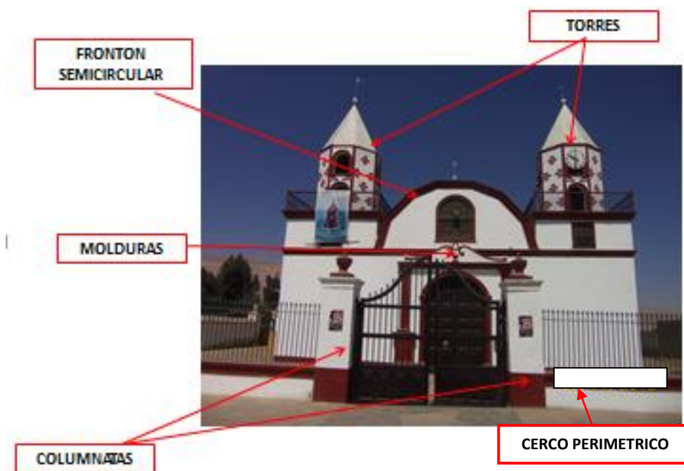
Imagen 09: Vista de elementos arquitectónicos de fachada principal
