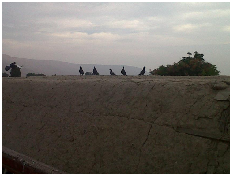
Imagen 46: Vista de techo tipo mojinete, nótese el recubrimiento externo de barro y paja.
