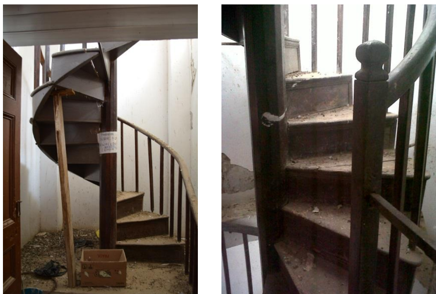
Imagen 37: Vista de estado actual la escalera de caracol ubicada en el campanario
