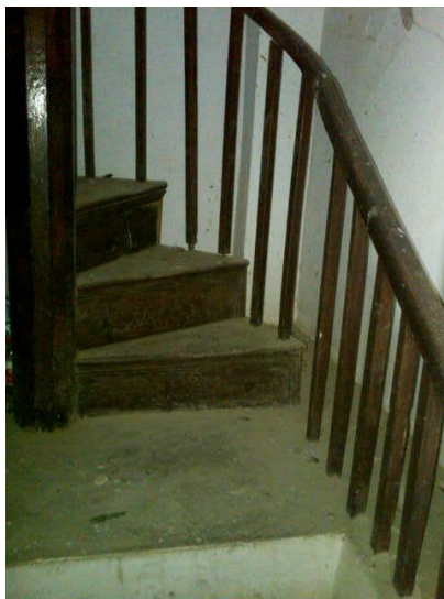
Imagen 35: Vista del estado actual del piso ubicado en el campanario
