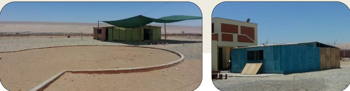
La falta de ambientes o aulas en el nivel primario, ha generado que se inprovisen ambientes con material prefabricado de carácter temporal, con techos y paredes de calamina y otros materiales no aptos para la infraestructura de un aula. Encontrándose en malas condiciones .
