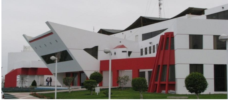
Figura 9: Fachada principal del Palacio Municipal de Iloen la Actualidad.
