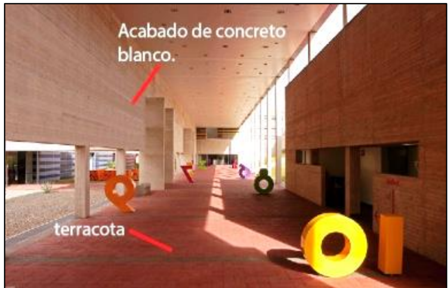
IMAGEN 6: MATERIALES DE ACABADOS
