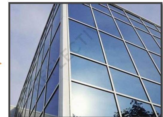
FIG. Nº 44 – FACHADA CON LÁMINAS DE CONTROL SOLAR..
