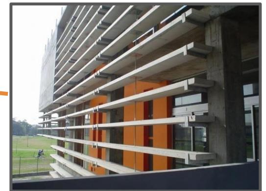
FIG. N° 46 – SOLUCIONES PARA EVITAR ASOLEAMIENTO Y VENTILACIÓN MUY DIRECTA HACIA LOS AMBIENTES DE TRABAJO.
