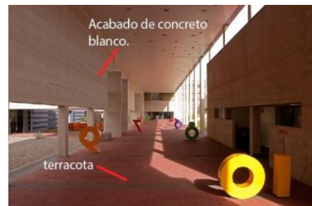
Imagen 16: Materiales de Acabados
