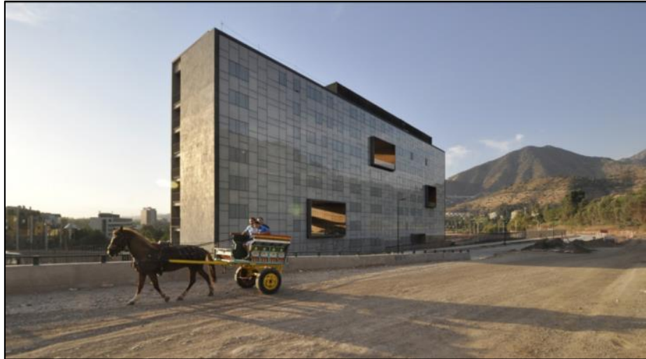
Figura 6. Vista Lateral de la Gran Barra y del tratamiento del Muro Cortina
