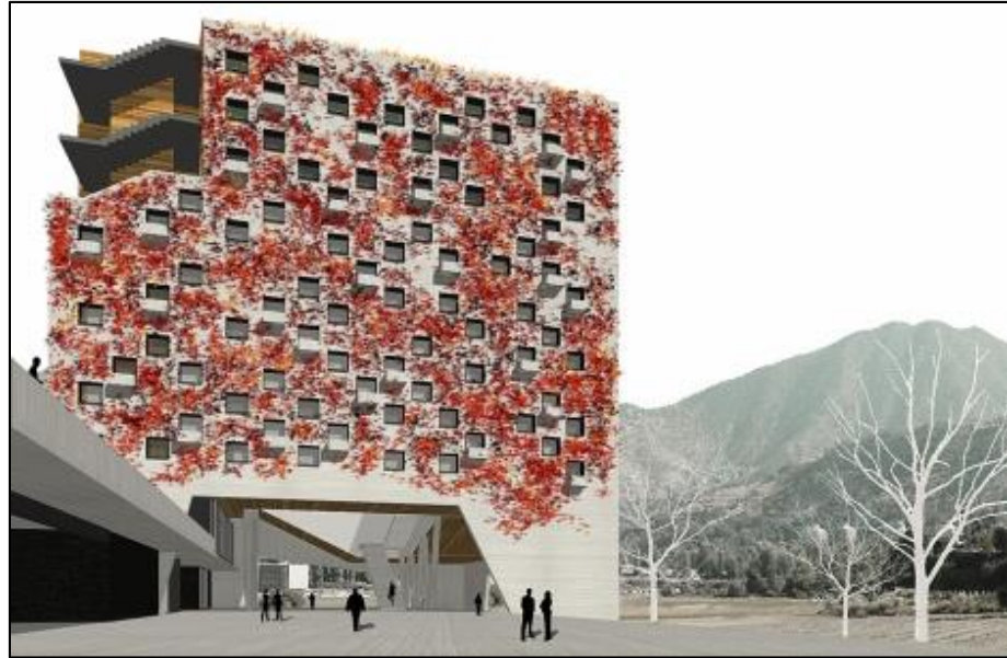
Figura 8. Vista del tratamiento del muro Verde - Fachada Lateral
