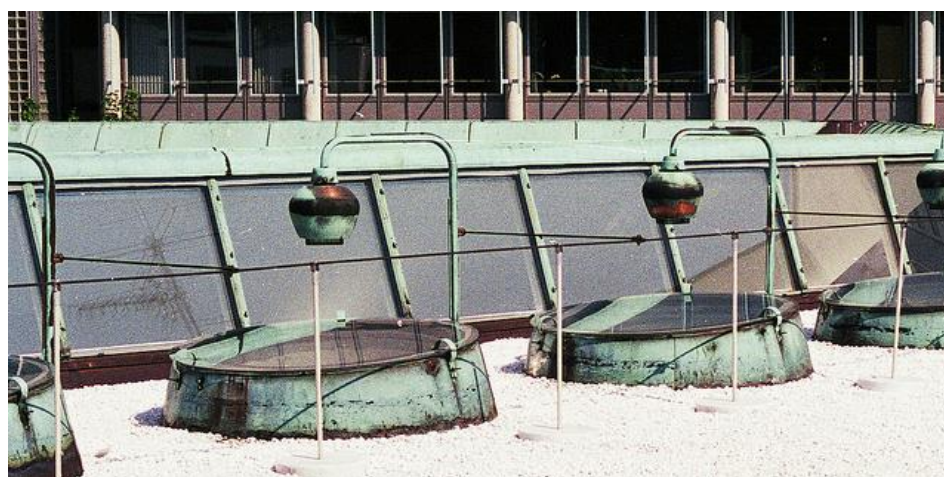
Figura 11. Vista de la Terraza - Tratamiento de Iluminación y Ventilación
