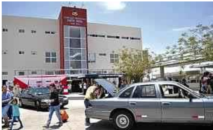
Figura 29. Vista de Puesto Fronterizo Santa Rosa
