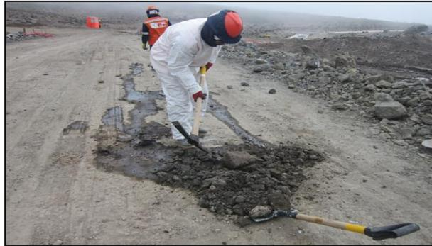
**Foto 5.6** Se retiró por completo el suelo contaminado.
