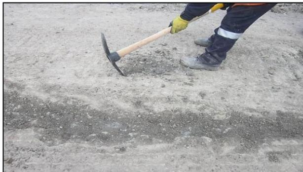
**Foto 5.7** Por efecto de la baja temperatura se gelatinizó, razón por lo que el aceite no filtró por completo en el suelo.
