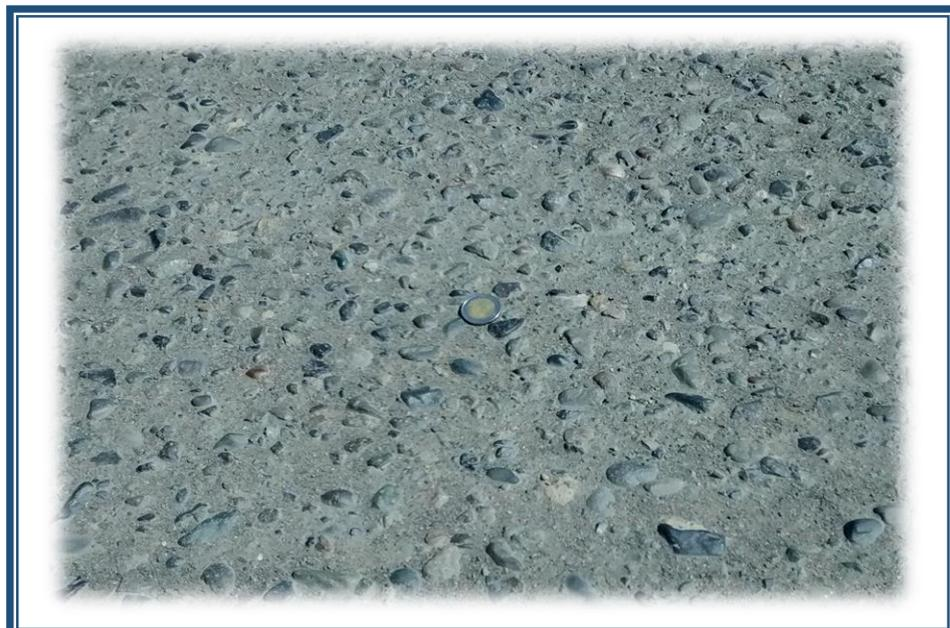
**FOTO N° 04:** Falla tipo disgregación presente entre las progresivas 00+400 hasta 05+400
