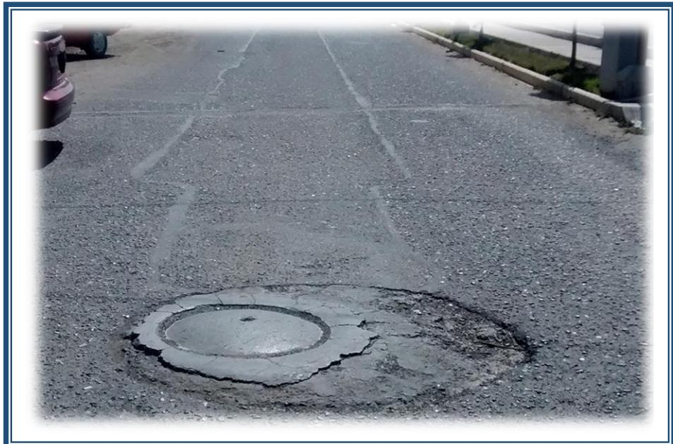
**FOTO N° 02:** Falla tipo parche presente entre las progresivas 00+400 hasta 05+000
