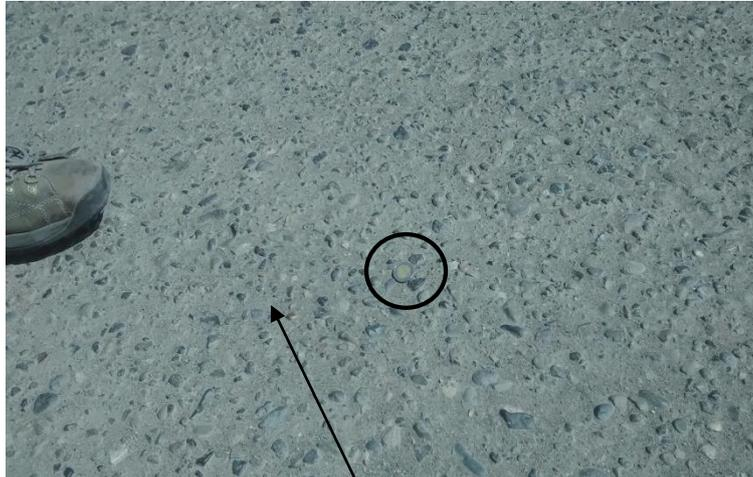
La fotografía muestra carpeta asfáltica con presencia de disgregación de materiales en la mezcla asfáltica. Km 02+000 a Km 10+000
