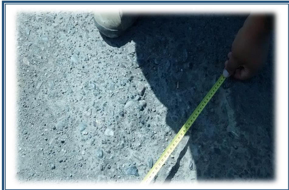
**FOTO N° 03:** Falla tipo hundimiento presente en la progresiva 00+800
