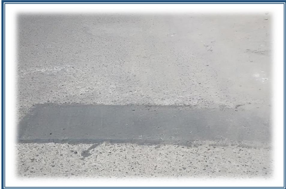
**FOTO N° 01:** Falla tipo parche presente entre las progresivas 00+400 hasta 05+000
