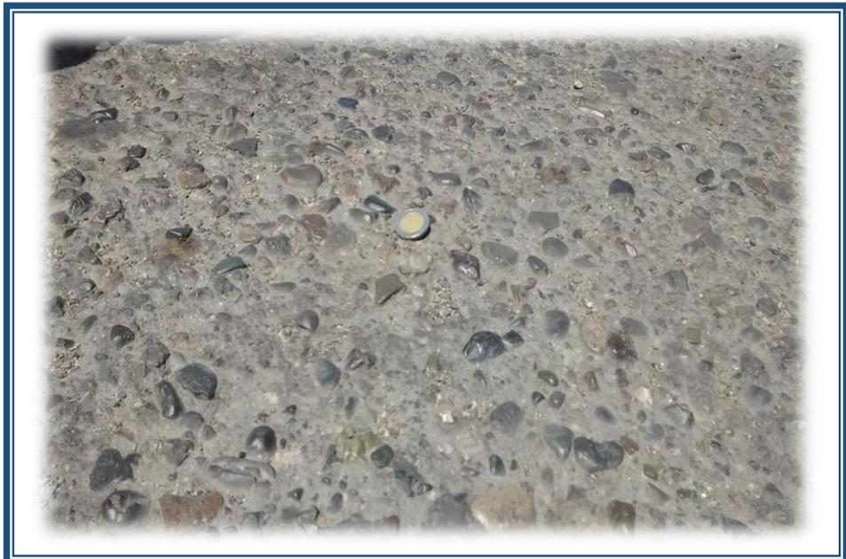
**FOTO N° 05:** Falla tipo disgregación presente entre las progresivas 05+500 hasta 10+000
