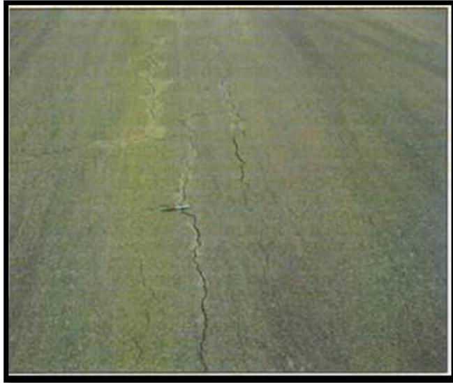
Como se aprecia en las vistas fotográficas, se tiene fisuras y grietas longitudinales que se han originado en las juntas de construcción de las carpetas asfálticas. La severidad es alta. Las fisuras longitudinales ya empiezan a ramificarse para formar fisuras en bloque.
