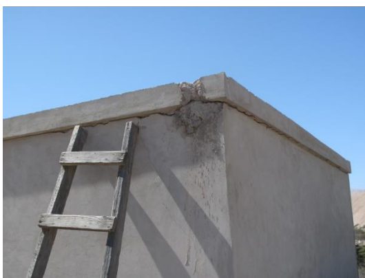
Imagen N° 18 y 19: Las imágenes muestran la cara trasera del reservorio, el cual muestra rajaduras, también se aprecia que no tiene escalera de acceso en el exterior para realizar los trabajos de limpieza.
