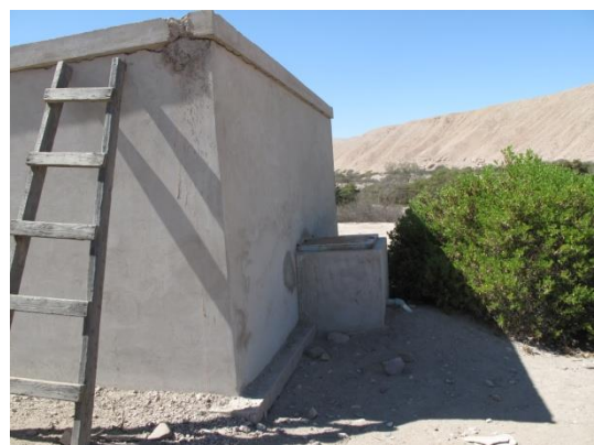
Imagen N° 18 y 19: Las imágenes muestran la cara trasera del reservorio, el cual muestra rajaduras, también se aprecia que no tiene escalera de acceso en el exterior para realizar los trabajos de limpieza.
