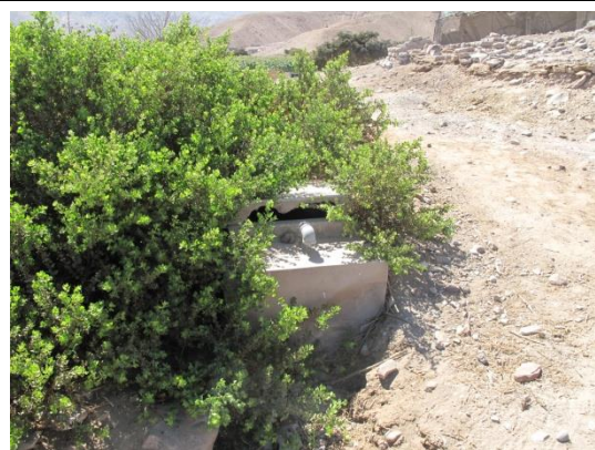
Imagen N° 10 y 11: En el lote rural N° 013670 del valle de Cinto se muestra los daños causados por los pobladores de cinto a la línea de conducción de agua potable.
