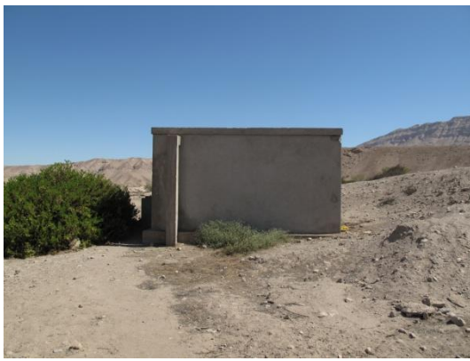
Imagen N° 16: En la imagen se observa el reservorio, el cual se encuentra a 73 m del Pozo N° 01.
