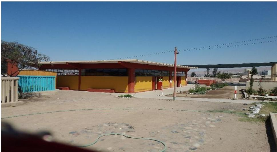
Vista de sistema estructural de pórticos de concreto armado en una de las direcciones principales. La NTE E030, prohíbe este tipo de sistema estructural en la zona 3 para edificaciones esenciales.
