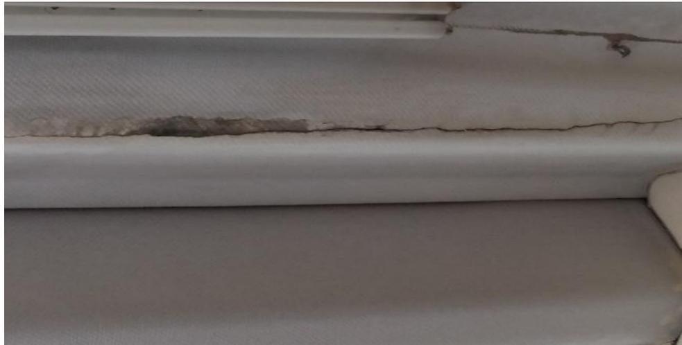
Deterioro del techo de fibrocemento tipo ondulado debido a la humedad y efecto de erosión del medio ambiente.
