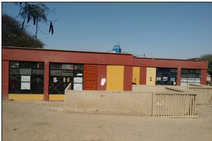
Figura 3.7.b. Vista Posterior del Edificio “D”
