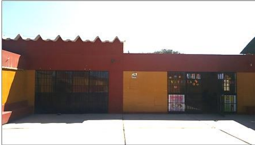
Vista de Fachada Principal.
