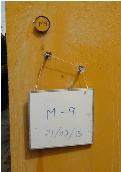
Vista de proceso de extracción de muestra M-9
