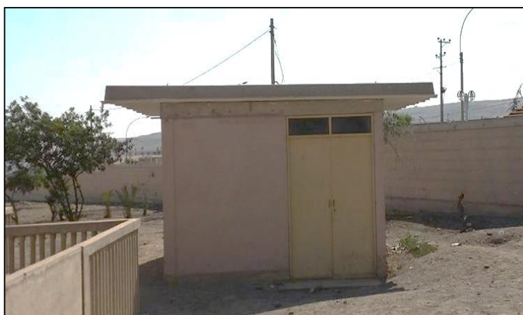
Figura 3.8. Vista Frontal del Edificio “L”
