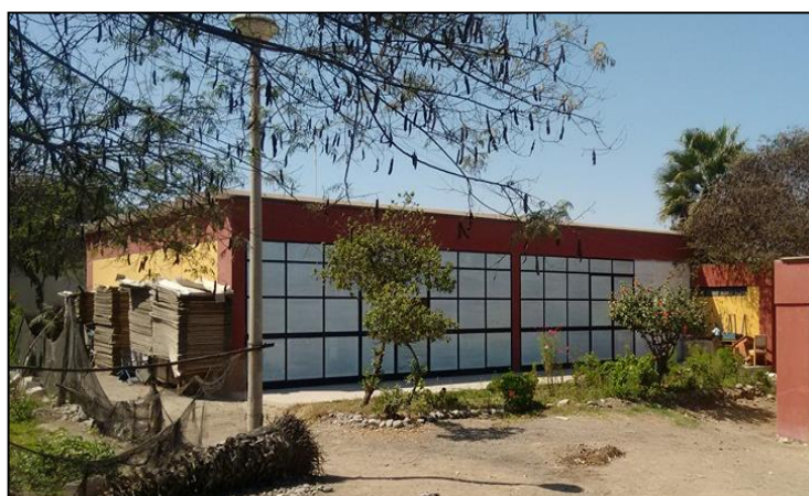
Figura 3.4.b. Vista Posterior del Edificio “A”
