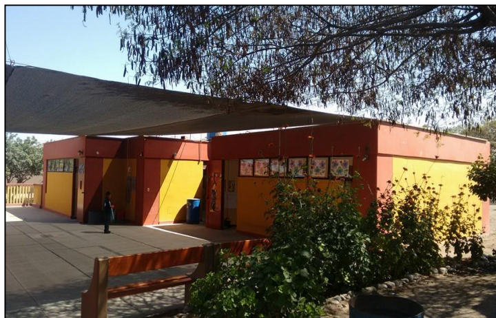
Figura 3.7.a. Vista Frontal del Edificio “D”
