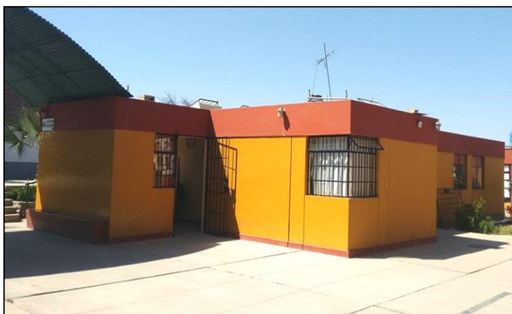
Figura 3.5. Vista Frontal del Edificio “B”
