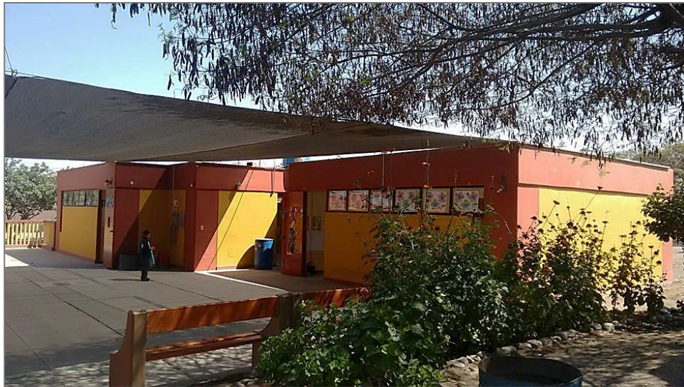
Vista de Fachada Principal.
