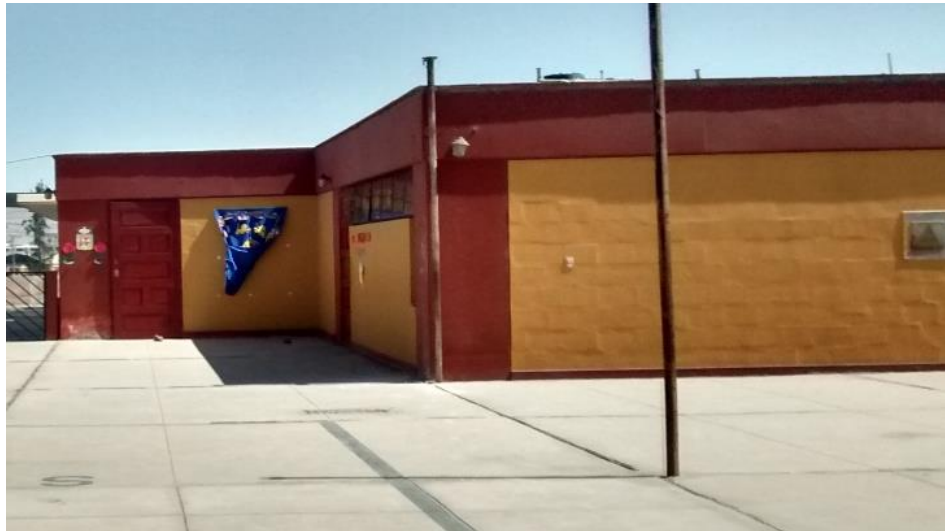
Figura 3.7 - Vista del Edificio "H"
