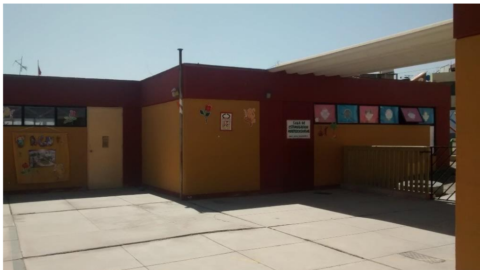
Figura 3.5 - Vista del Edificio "F"
