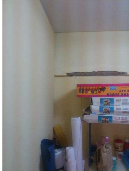
Presencia de grietas en los encuentros de muros y vigas, esto se ha ocasionado por ausencia de juntas dilatación.
