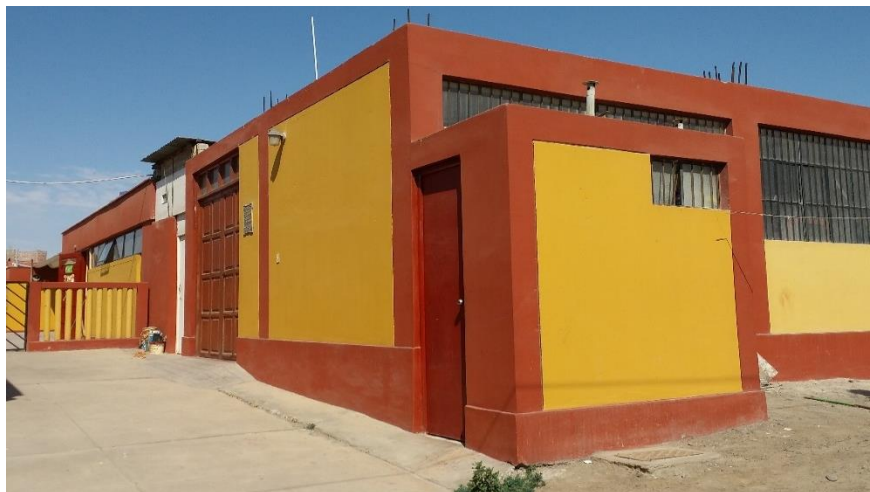
Figura 3.8 - Vista del Edificio "K"
