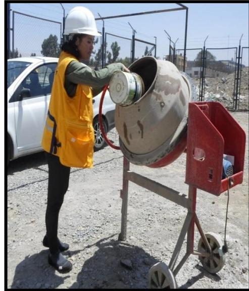
Colocación de los materiales en el trompito eléctrico para la elaboración de la mezcla definitiva.
