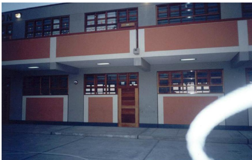
Centro Educativo construido con las Normas del año 1997.
