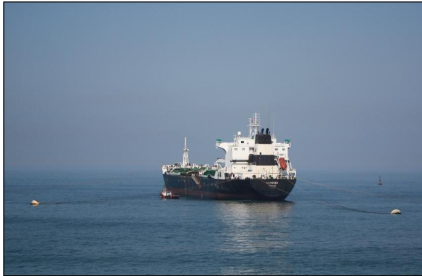
Figura N°21. Terminal Multiboyas de Tablones
